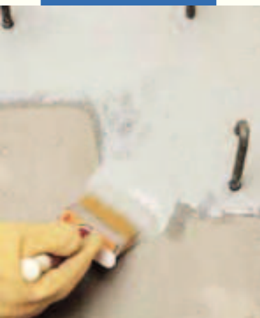
Нанесение Eporip кистью на рабочий шов бетонирования
